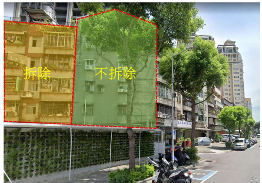
西側鄰房拆除：63-3號 65巷10號
