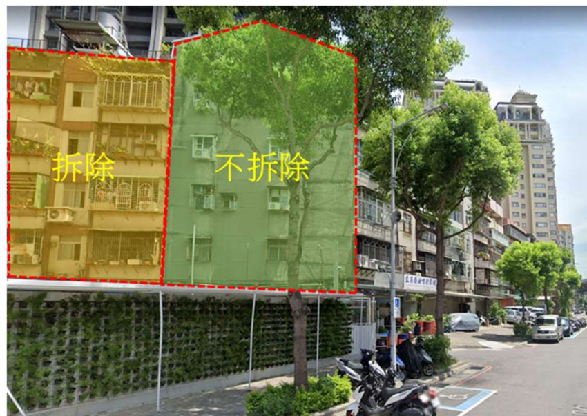
西側鄰房拆除：63-3號 65巷10號
